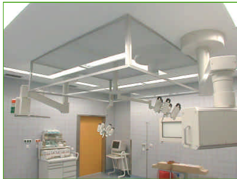
Operationsaal im DRK-Krankenhaus in Neuwied, Deutschland, eingerichtet mit ADMECO-Air Zuluftdecke Typ FFA mit Luftleitschürze aus Verbundsicherheitsglas
